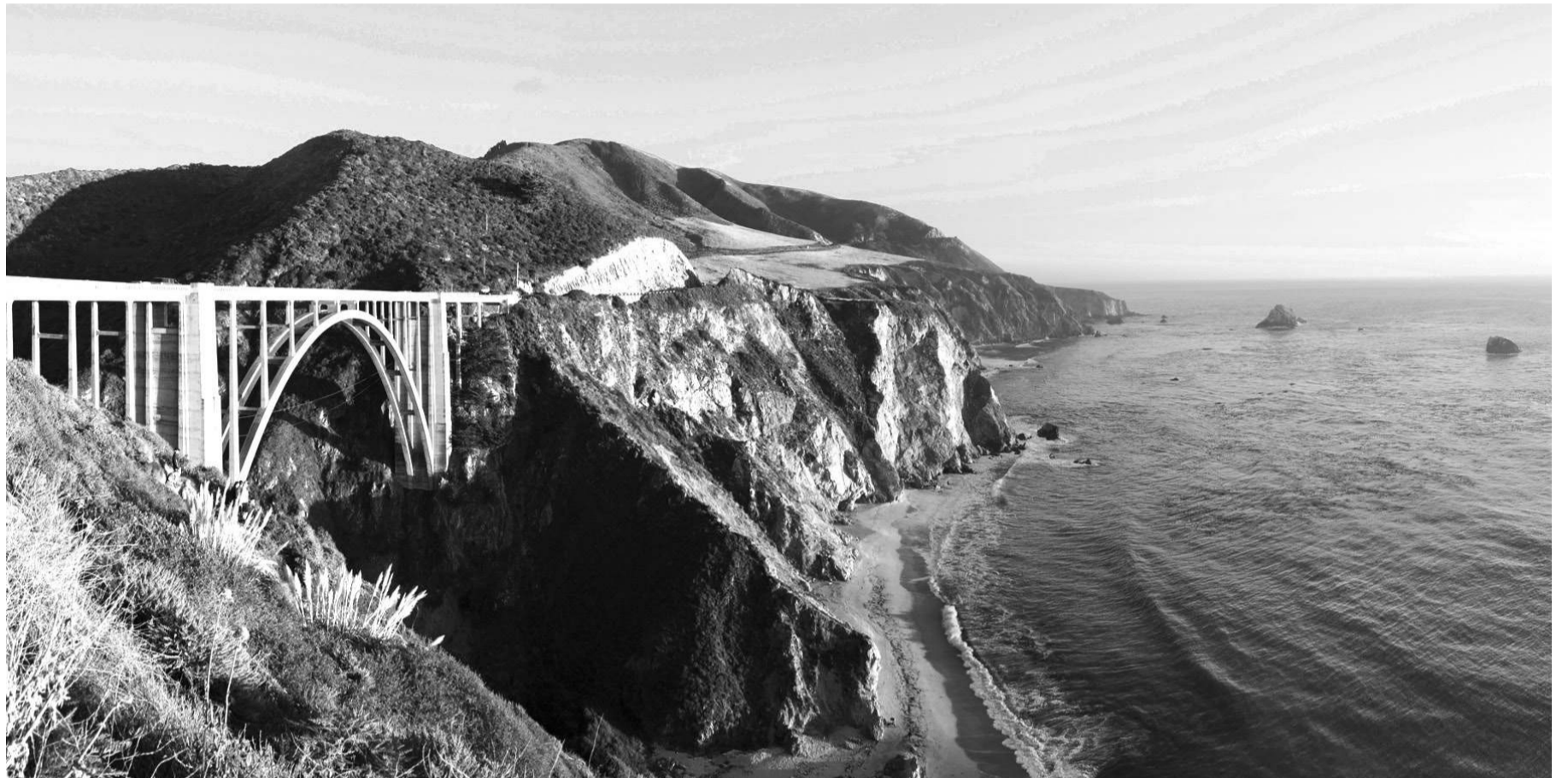
Sécheresse, incendies, pluies: soumis à rude épreuve, le sol s'est effondré en plusieurs endroits. Mais la route 1 est de nouveau ouverte. CECILE MICHEL
